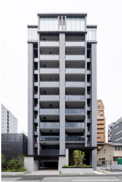
外観竣工写真
